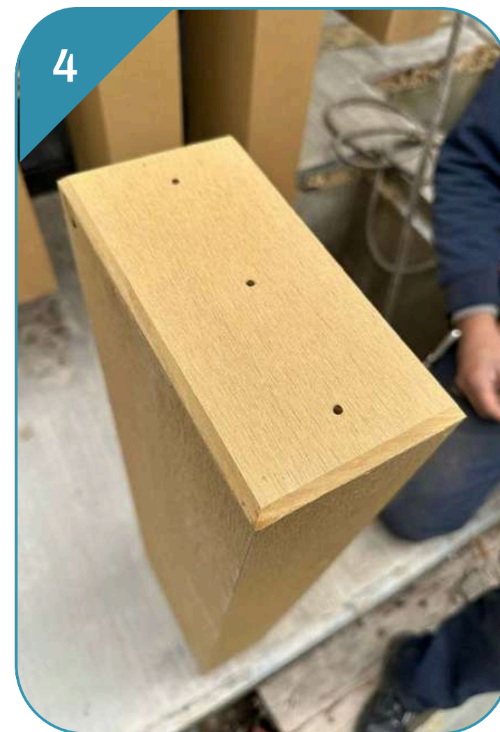
TAPONES DE FIJACIÓN CON DRENAJES PARA VENTILACIÓN
