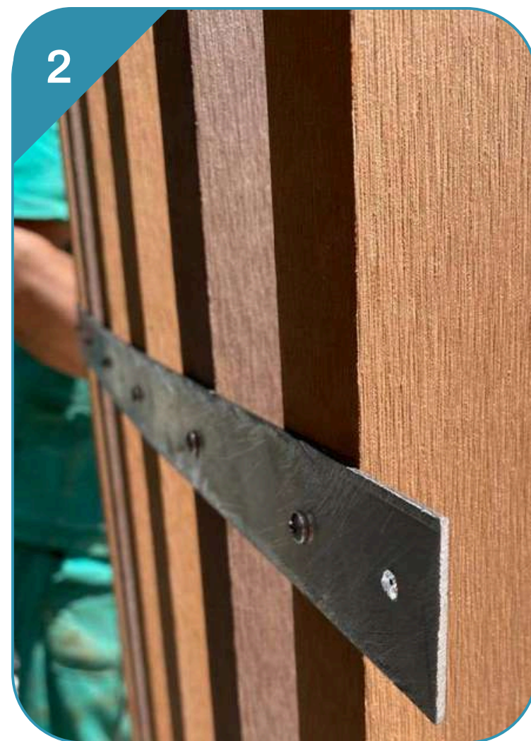
FIJACIÓN A BARRA PLANA METÁLICA
