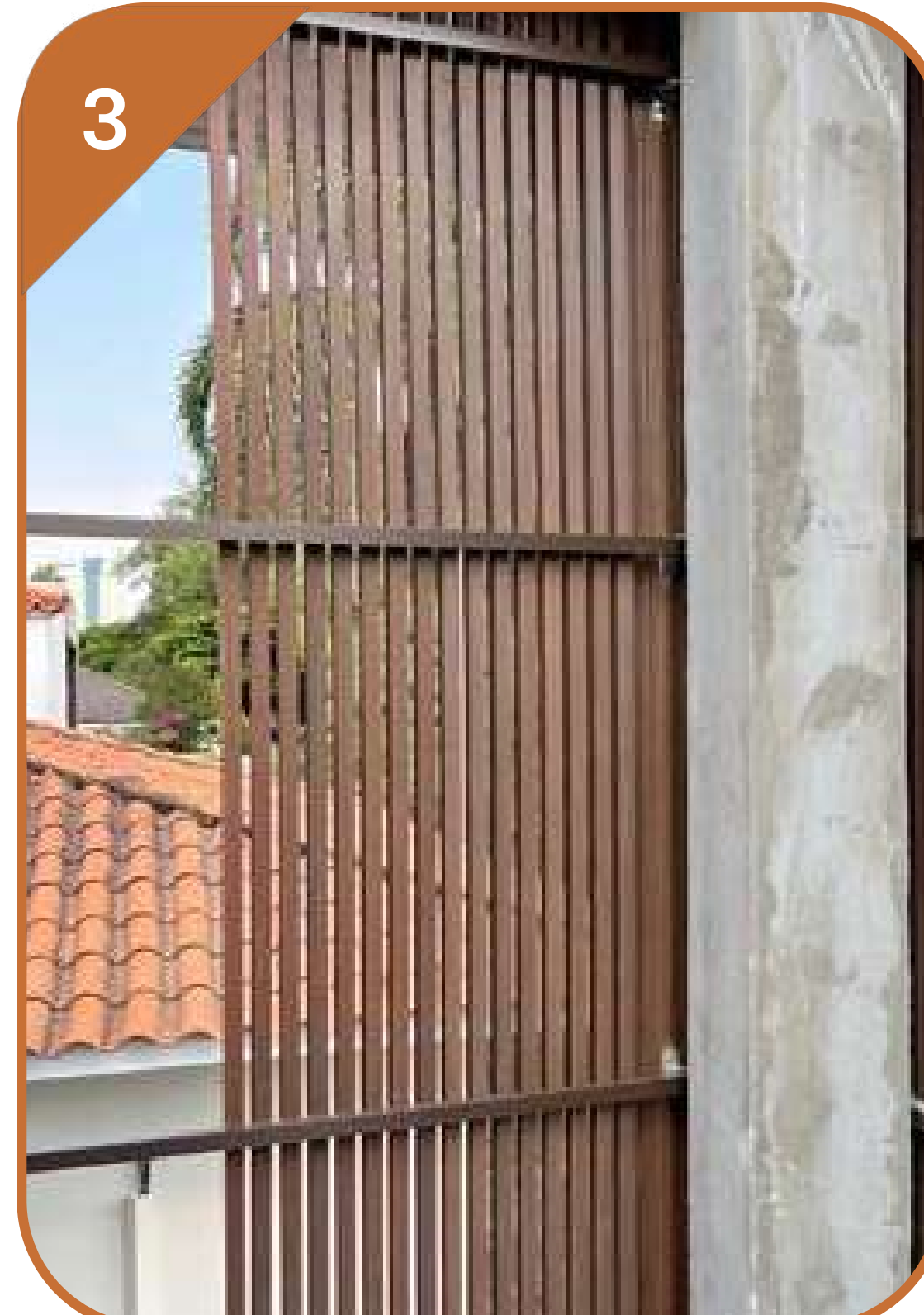
FIJACIÓN EN CARPINTERÍA METÁLICA / MAMPOSTERÍA
