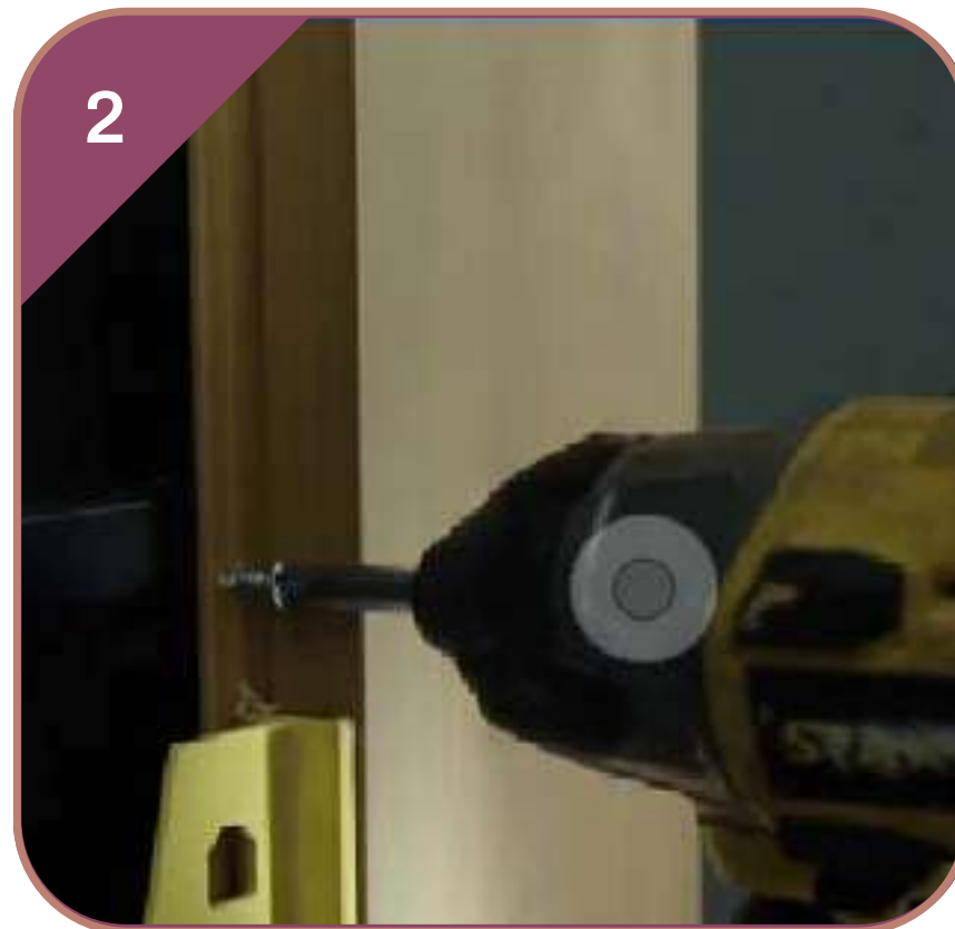
FIJACIÓN DE LAS ESCUADRAS Y COLOCACIÓN DE LOS PERFILES
