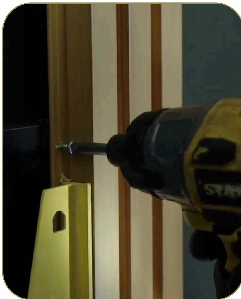
ATORNILLADO DE LAS SUBESTRUCTURAS
