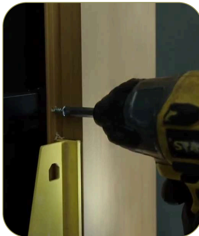
PARAFUSAÇÃO DAS CANTONEIRAS E APLICAÇÃO DOS PERFIS
