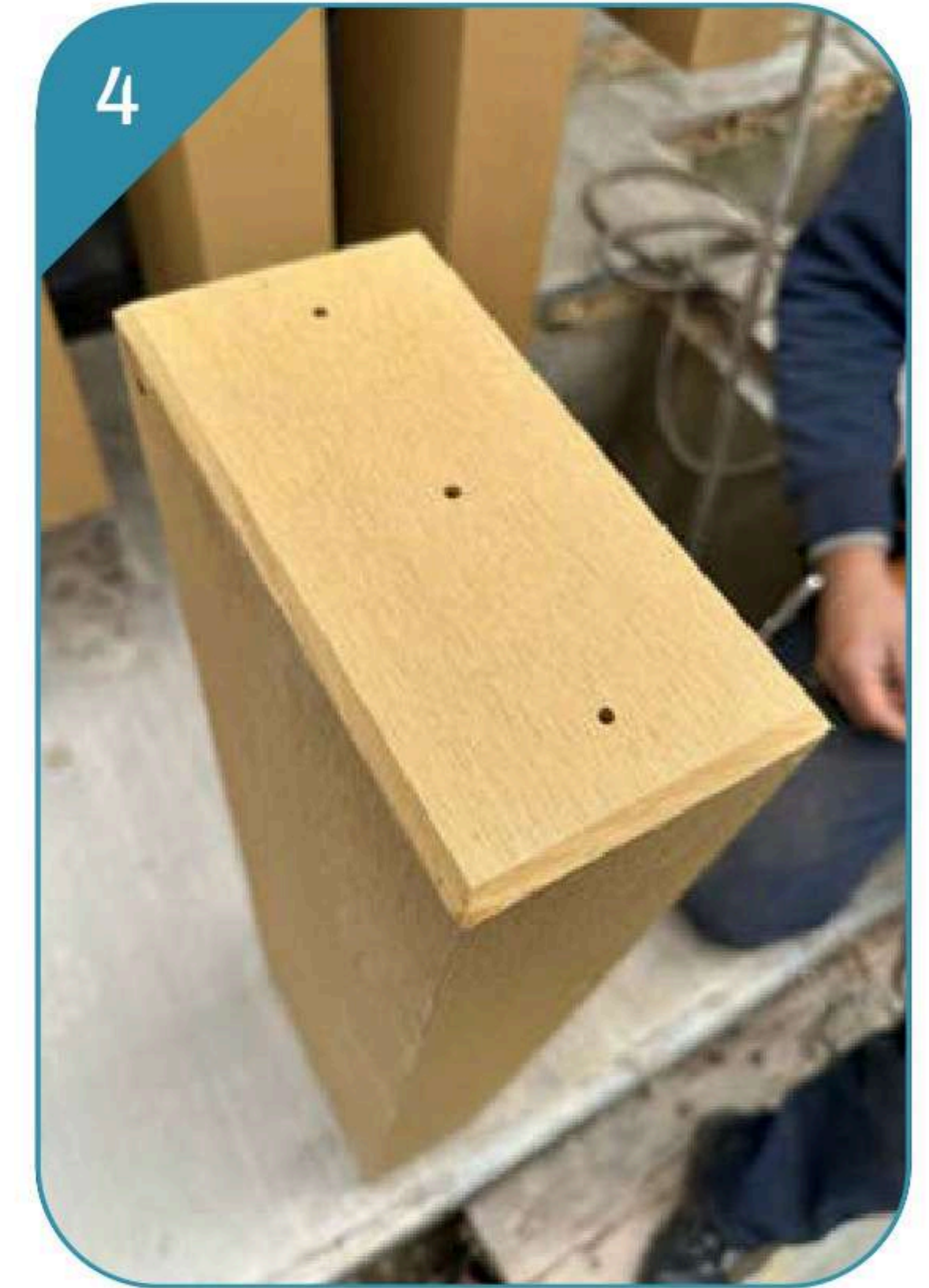
TAPAS DE FIJACIÓN CON DRENAJES PARA VENTILACIÓN
