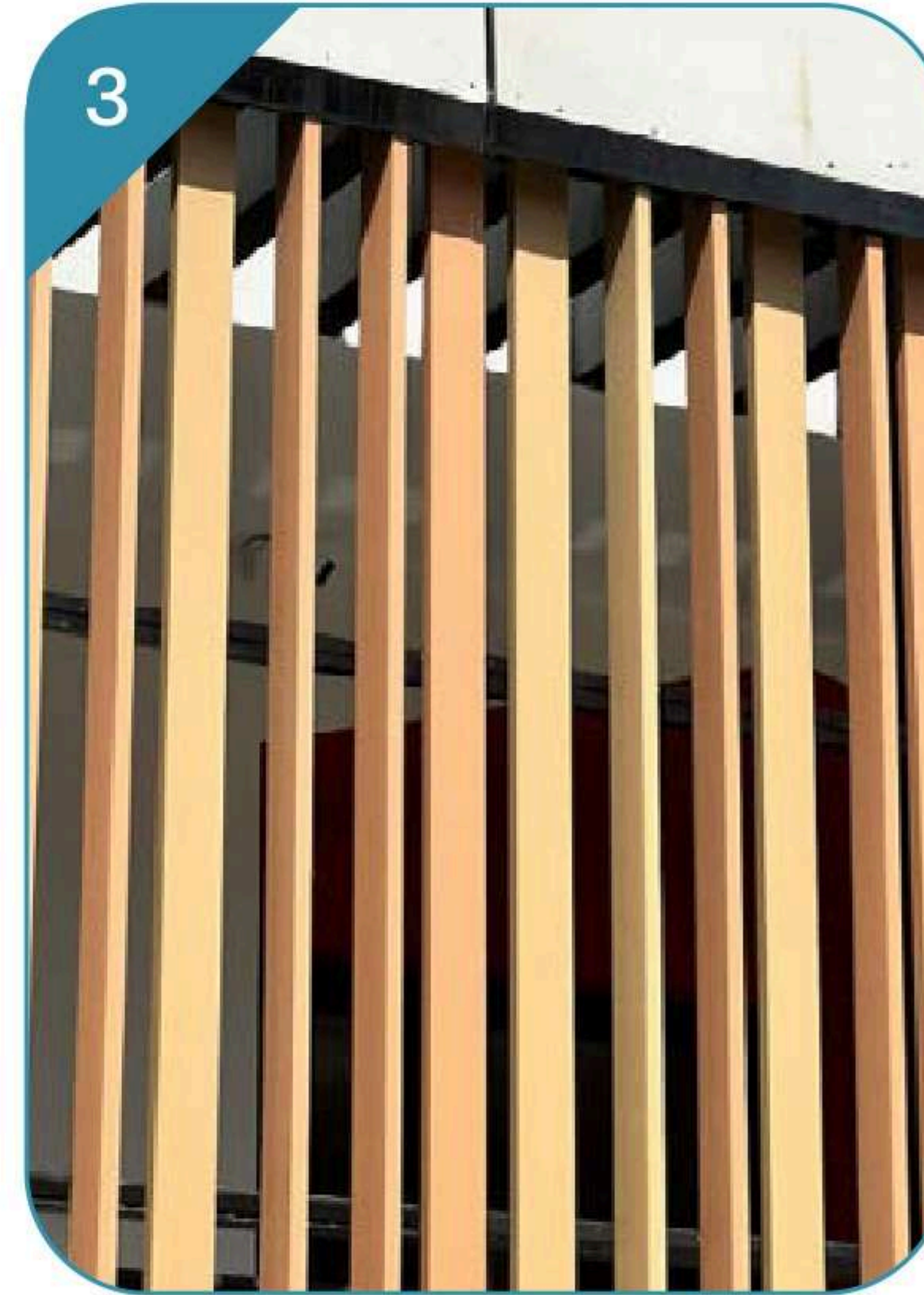
FIJACIÓN DEL MODULO A ESTRUCTURA METALICA EXISTENTE
