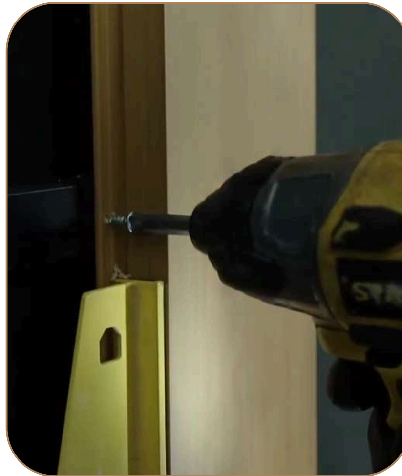
ATORNILLADO DE LAS CANTONERAS Y APLICACIÓN DE LOS PERFILES
